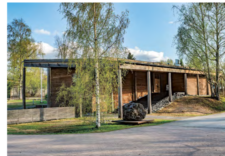
Juminkeon näyttävyttä lisäävät turvekattoa kannattelevat hirsipilarit.
